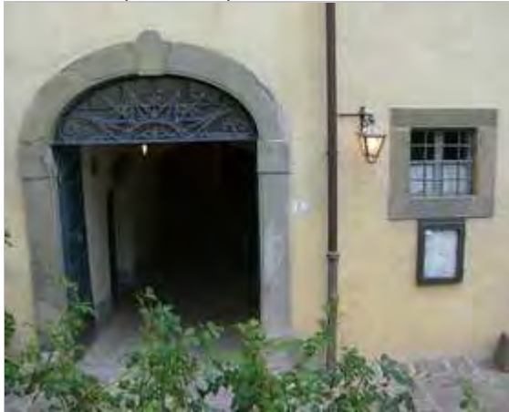
Categoria: Caratteristiche architettoniche e strutturali
