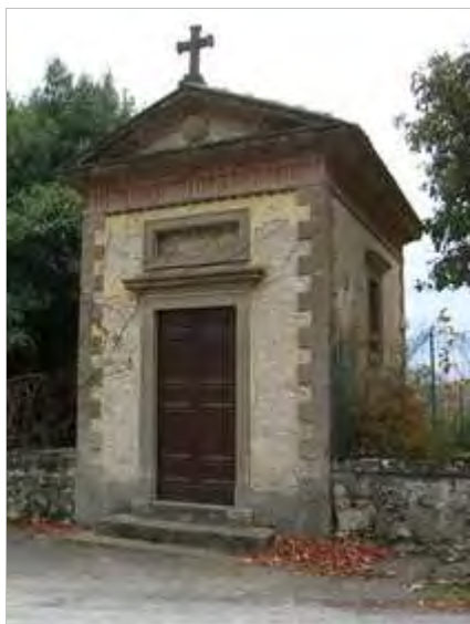
Categoria: Edificio FOTO n° 428 (edificio 231)
