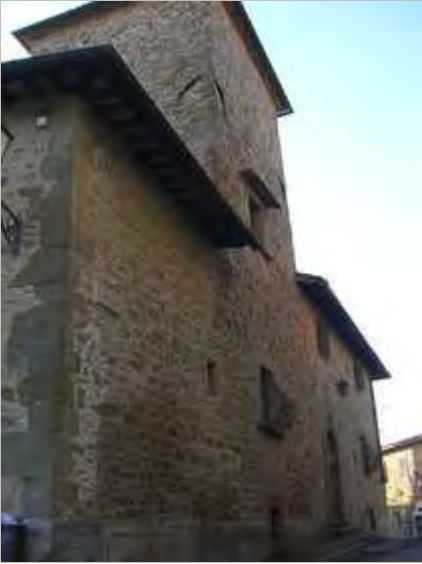
Categoria: Edificio FOTO n° 1185 (edificio 402)
