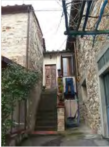
Categoria: Edificio FOTO n° 2491 (edificio 724)
