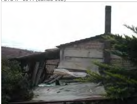
Categoria: Degrado architettonico/incongruità
