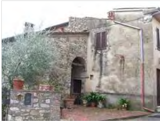
Categoria: Edificio FOTO n° 2504 (edificio 725)
