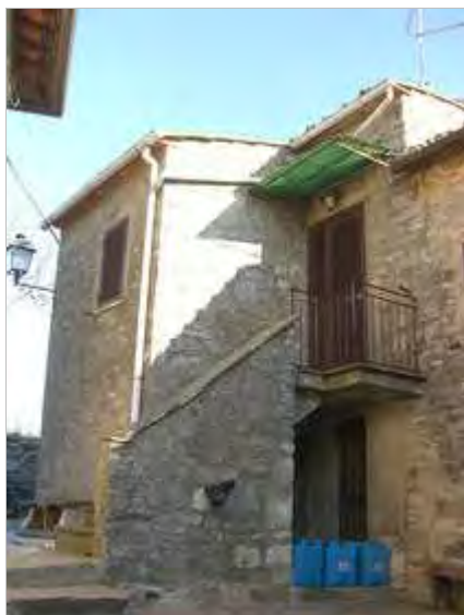
Categoria: Edificio FOTO n° 1204 (edificio 432)
