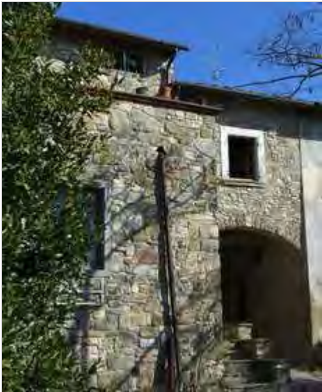
Categoria: Edificio FOTO n° 1297 (edificio 450)
