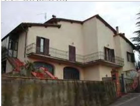
Categoria: Degrado architettonico/incongruità
