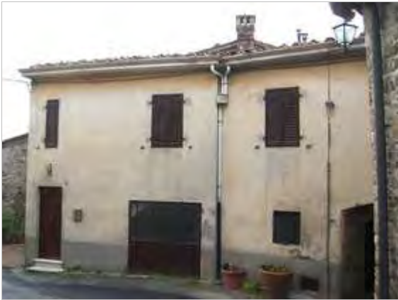
Categoria: Edificio FOTO n° 2503 (edificio 725)
