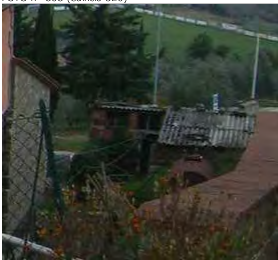
Categoria: Degrado architettonico/incongruità
