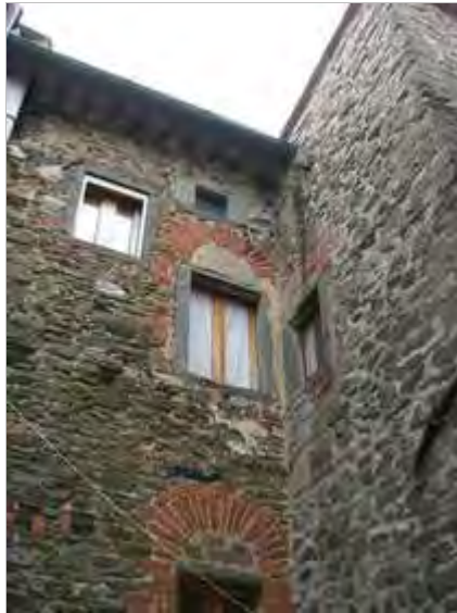
Categoria: Edificio FOTO n° 1583 (edificio 406)
