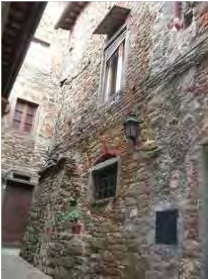
Categoria: Edificio FOTO n° 1582 (edificio 406)
