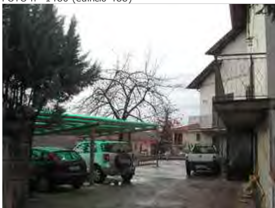
Categoria: Degrado architettonico/incongruità
