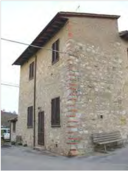
Categoria: Edificio FOTO n° 1232 (edificio 436)
