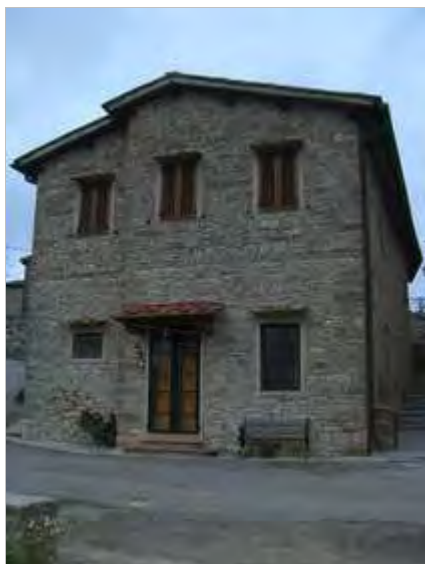
Categoria: Edificio FOTO n° 1127 (edificio 420)
