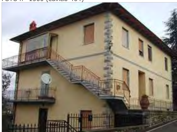
Categoria: Degrado architettonico/incongruità
