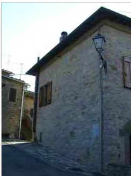
Categoria: Edificio FOTO n° 1149 (edificio 425)
