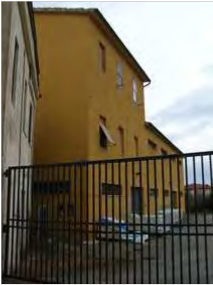
Categoria: pertinenza/Cortile FOTO n° 461 (edificio 242)
