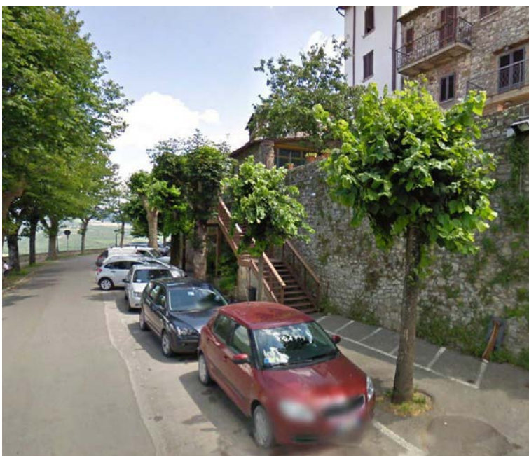
Fotografie 18 e 19 - La pavimentazione risulta parzialmente sconnessa lungo tutto il marciapiede a causa della presenza delle radici degli alberi leggermente affioranti e della vegetazione cresciuta nelle parti sconnesse del selciato.
