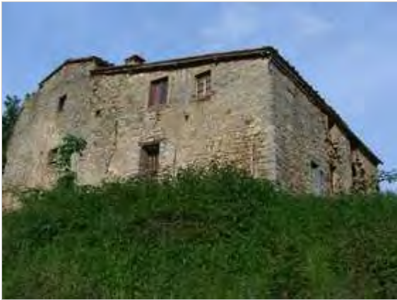
Categoria: Degrado fisico
