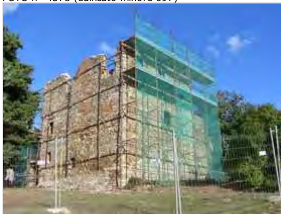
Categoria: Degrado fisico
