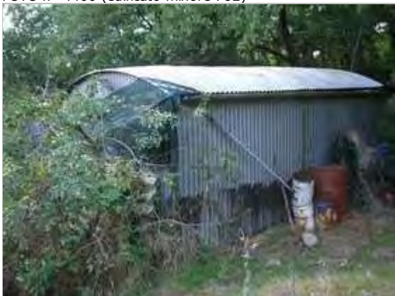
Categoria: Degrado fisico
