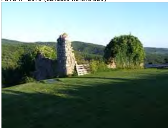
Categoria: Degrado fisico
