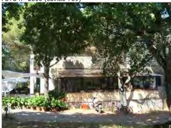
Categoria: Degrado architettonico/incongruità
