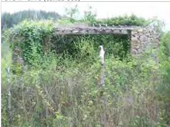
Categoria: Degrado fisico
