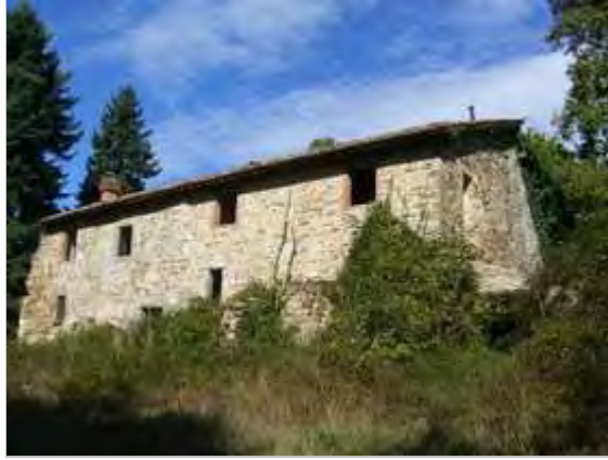
Categoria: Degrado fisico
