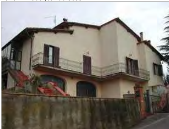
Categoria: Degrado architettonico/incongruità
