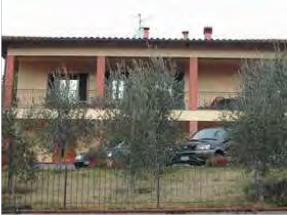
Categoria: Caratteristiche architettoniche e strutturali
