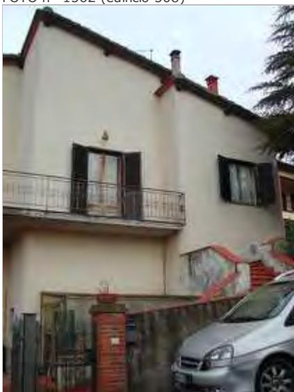
Categoria: Degrado architettonico/incongruità
