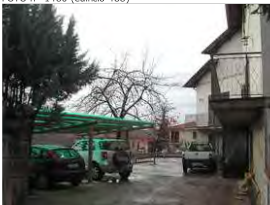
Categoria: Degrado architettonico/incongruità
