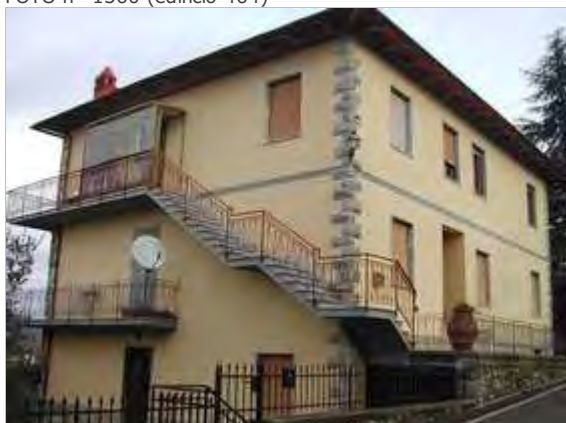
Categoria: Degrado architettonico/incongruità
