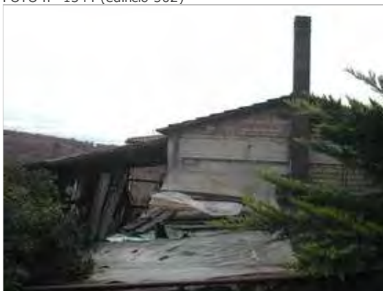
Categoria: Degrado architettonico/incongruità
