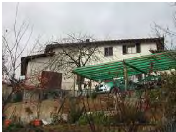
Categoria: Degrado architettonico/incongruità
