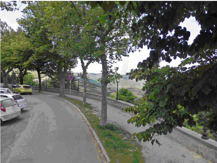
Fotografie 18 e 19 - La pavimentazione risulta parzialmente sconnessa lungo tutto il marciapiede a causa della presenza delle radici degli alberi leggermente affioranti e della vegetazione cresciuta nelle parti sconnesse del selciato.
