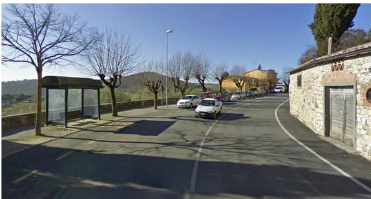
Fotografia 11 - Lungo via XX settembre è presente anche la fermata della linea di servizio del trasporto pubblico, dotata di apposita pensilina. Il percorso pedonale pertanto risulta particolarmente difficoltoso per le persone disabili – specie se su sedia a rotelle – a causa dell'ampiezza ridotta e della pavimentazione con risalti e sconnessioni.
