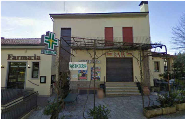
Fotografia 5 - Il Cinema, come la Farmacia, si trova su un livello più alto rispetto al piano di calpestio del marciapiede del viale. Il dislivello viene risolto attraverso quattro scalini, privi di servoscala.
