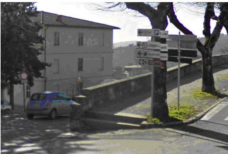
Fotografia 6 - In corrispondenza del doppio attraversamento pedonale si riscontra da una parte la presenza di due scalini che rendono inaccessibile l'ingresso alle carrozzine e dall'altro, sebbene sia presente solo un piccolo scalino, è comunque assente una differenziazione tattile delle pavimentazioni ed una guida tattile indicante la mezzera dell'attraversamento pedonale ad uso delle persone cieche
