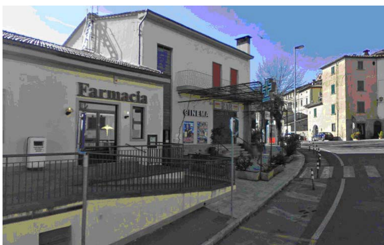
Fotografia 4 - La Farmacia comunale si trova su un livello più alto rispetto al piano di calpestio del marciapiede del viale.
