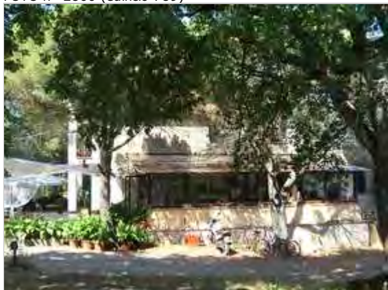
Categoria: Degrado architettonico/incongruità
