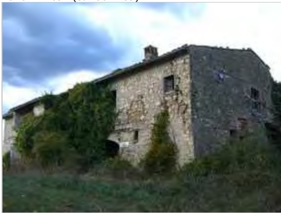
Categoria: Degrado fisico
