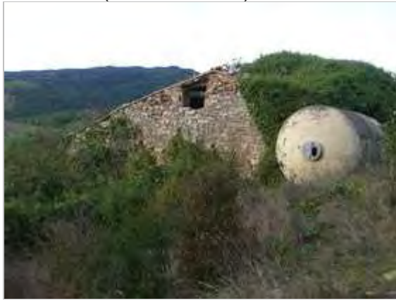
Categoria: Degrado fisico
