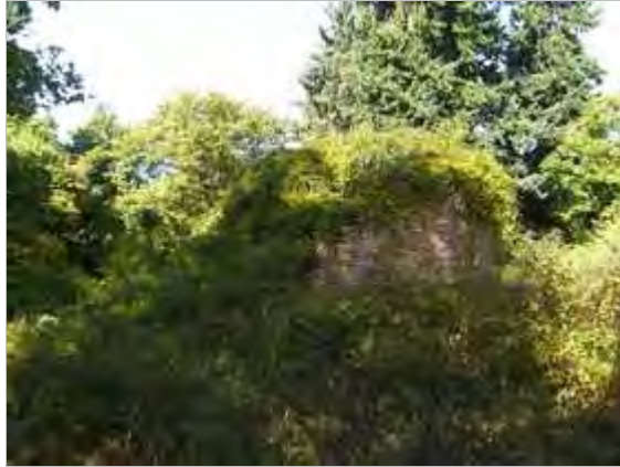
Categoria: Degrado fisico
