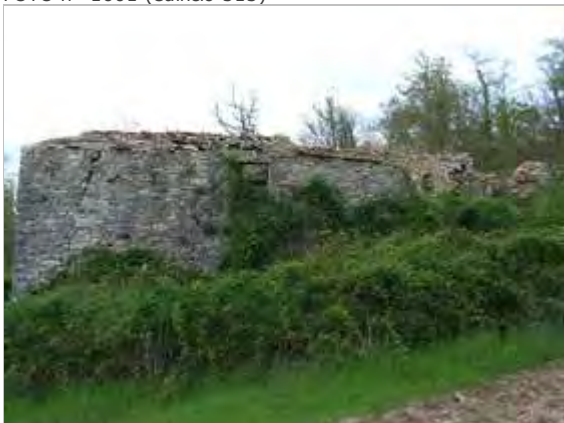
Categoria: Degrado fisico
